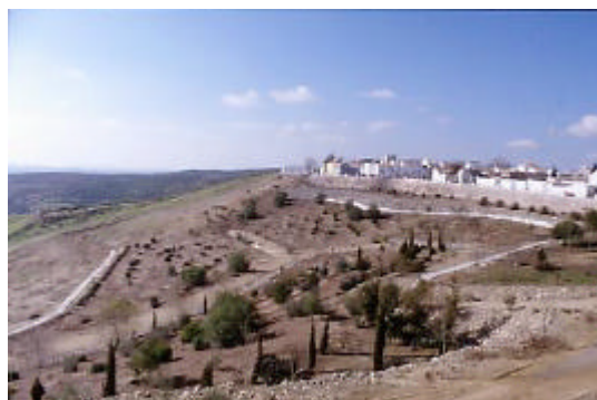
Vista de "La Grieta", una vez finalizados los trabajos de estabilización de la ladera
