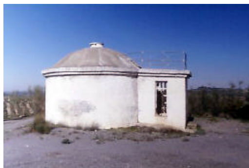
Depósito de agua de El Tejar
